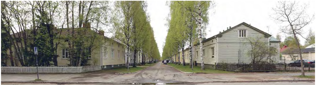
Kuva 22. Karjakatu Tehtaankadulta kuvattuna. Raksilan katutilat ja katujulkisivut ovat hyvin säilyneet. Kuva: Riitta Kosonen.
