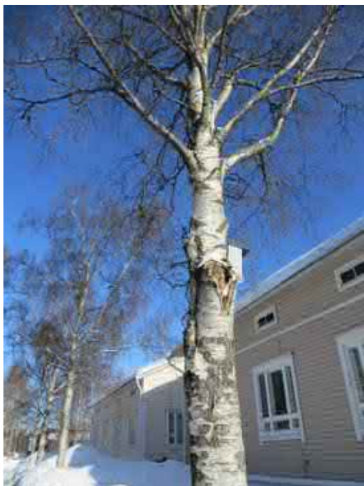
Kuva 26. Vaurioitunut koivu Karjakadulla.
